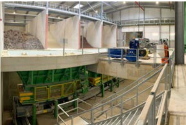
Inbetriebnahme der neuen Aufbereitung installation of the new preparation plant
